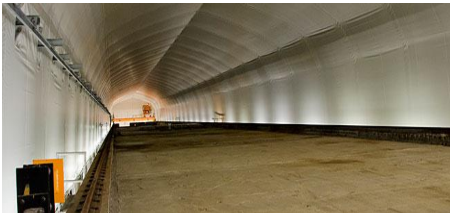
Figur 21. Tunnelduk i SFR skapar en torr och ljus miljö (Foto: http://www.skb.se ).
