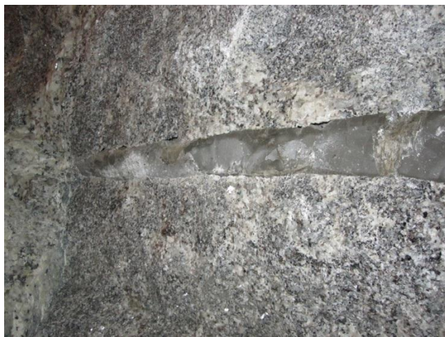
Figur 7. Hålfyllning från hålbotten med bruk vct 0,3 och tillsats av Intraplast A som ger låg viskositet vid pumpning samt svällning av bruket efter pumpning. Hålet är helt fyllt med en hård cementkärna. Flagor från bruket upptill i hålet har lossnat vid sprängning som blottade hålet där det kommer in i tunneln (Foto: Bogdanoff, 2011).
