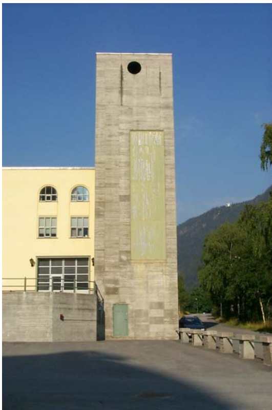
Figur 8. Bilden visar betongtornet i vilket Kuhnkolonnen i figur 7 är innesluten.
