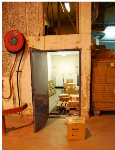
Bild 5: ”Radiak” rummet med ståldörr. I förgrunden en teknetiumgenerator med TI 1,9.
