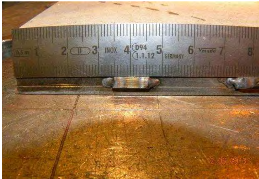
Figur 10 Kontrollmätning av defekt Nr 1.
