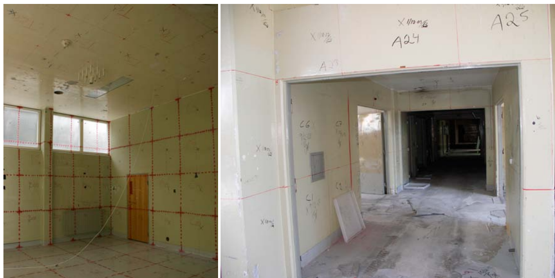
Figur 4-2. Pågående arbete med friklassning.
