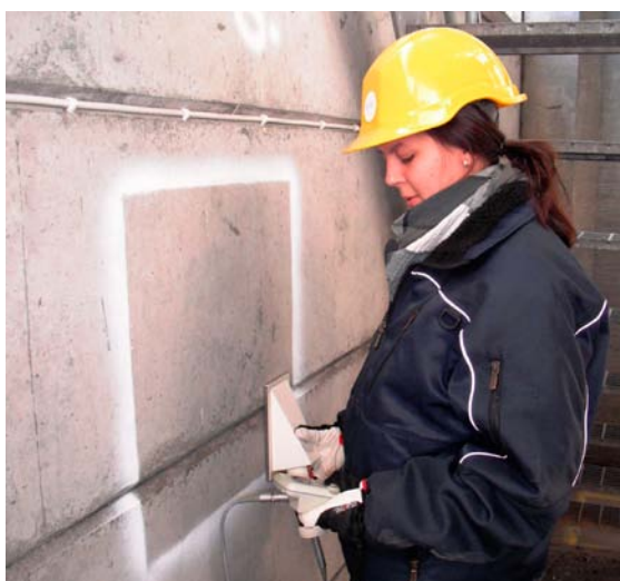
Figur 5-2. Mätning med pulsratsinstrument i en lokal.
