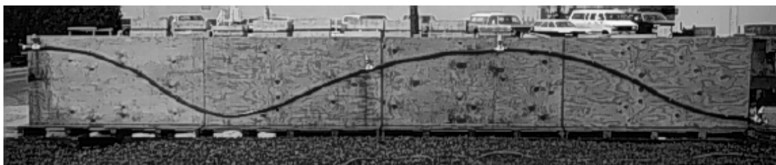
Figur 39: Kabelrör för provinjekteringar. (Schokker et al. 1999)
