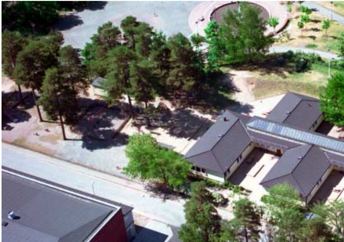
Bild 3-4. Flygfoto av förskolan Eken och förstoring av lekinstallationer i skugga. Foto: Sv. Aero-Bilder AB
