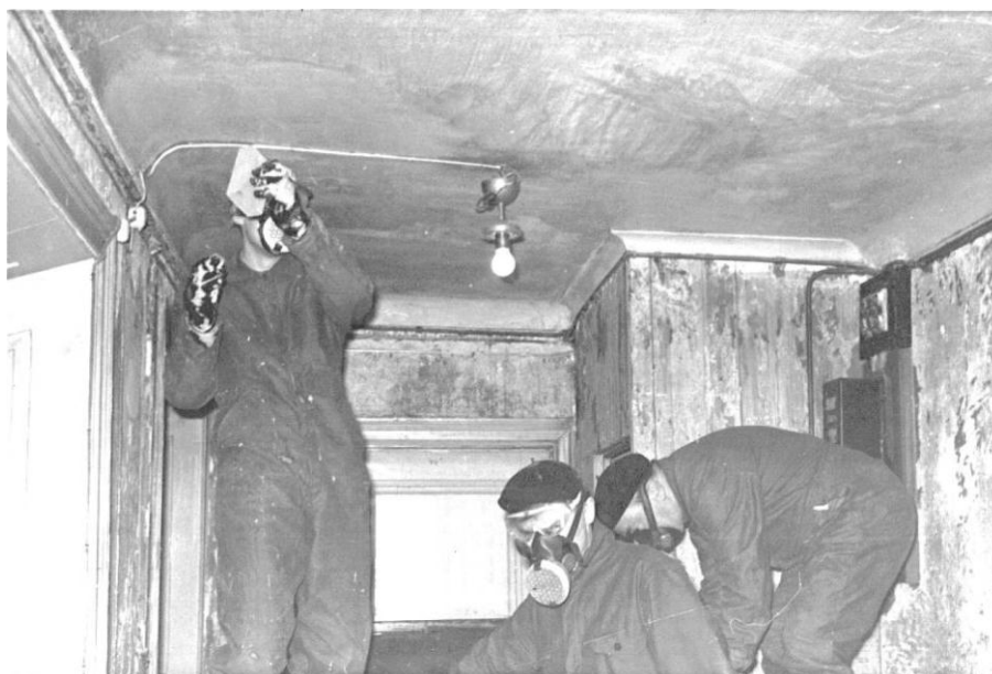
Figur 12.2 Interiör från saneringsarbetet i Scheers verkstad.
