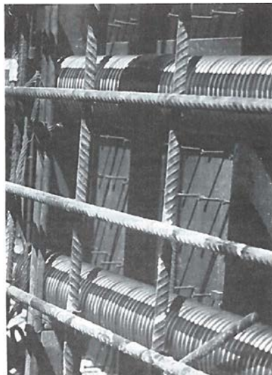
Figur 3.4: Foto av monterad slakarmering och foderrör i inneslutningsvägg [3].
