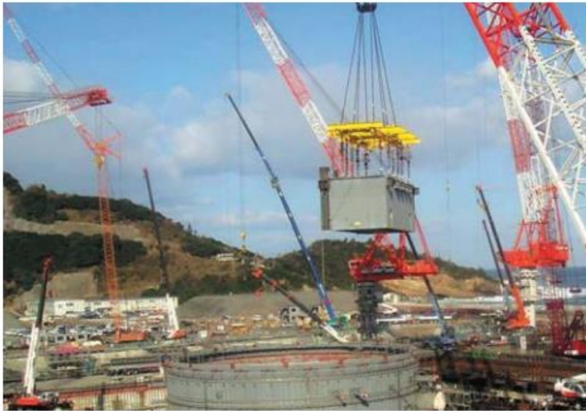
Figur 6.7: Modul konstruerat av SC-väggar och som innehåller det hydrauliska systemet för drivdonen lyfts på plats på Shimane 3. Bild från [47].
