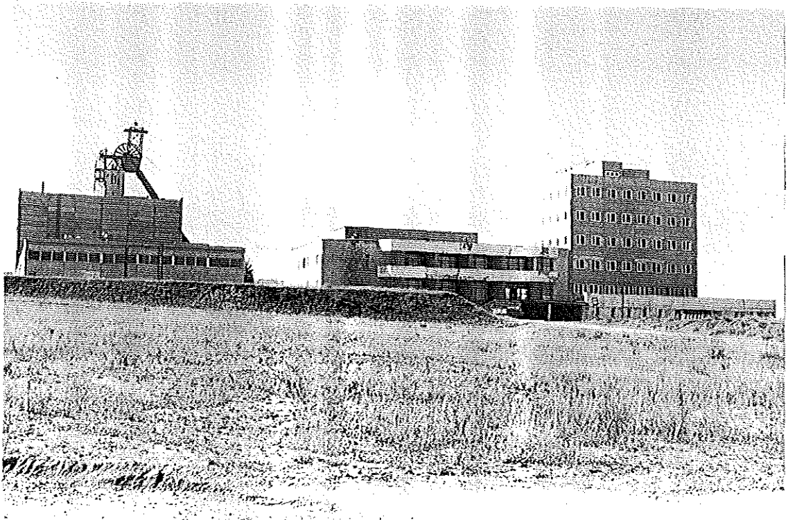
Gruvlave (till vänster) samt byggnad för ventilationsluft till underjordsgruvan
